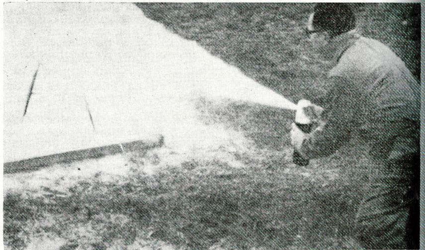
El fuego de carburador es apagado después de 12 segundos por medio de un extintor conteniendo 1 kg. de polvo ABC.
